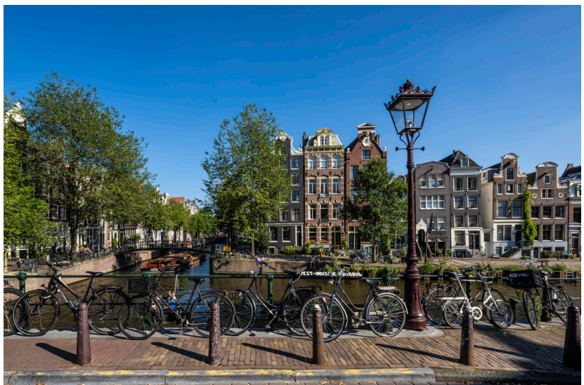
Mast 1883 met Kroonarmatuur
