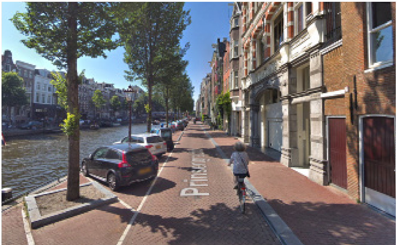
De afgelopen twee decennia is hard gewerkt aan het uitrollen van het standaard grachtenprofiel in stadsdeel Centrum. Hier een uitgevoerd gedeelte van de Prinsengracht met de bekende hardstenen banden, boomkransen, kroonlantaarns en bakstenen bestrating.
