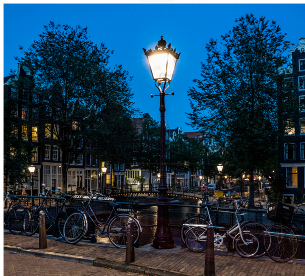
Mast 1883 met Kroonarmatuur
