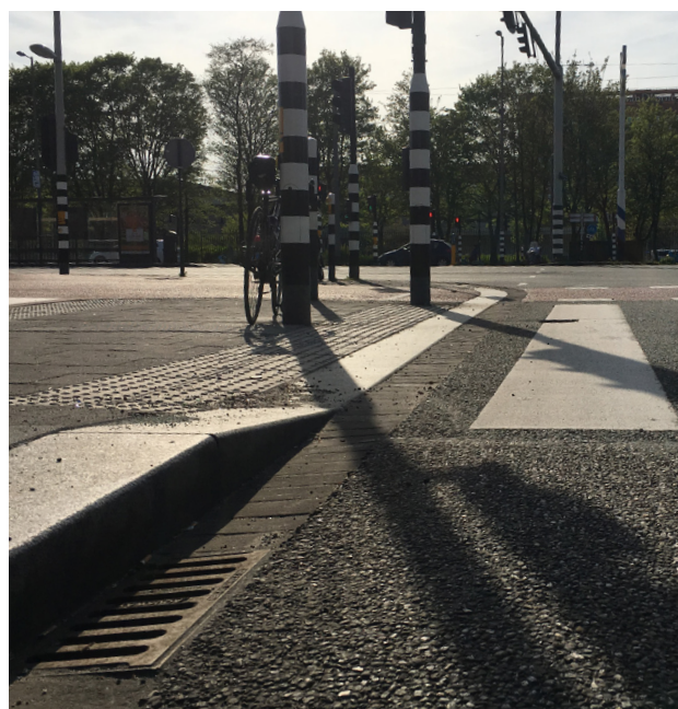
Oversteken zo vlak mogelijk aanleggen!
