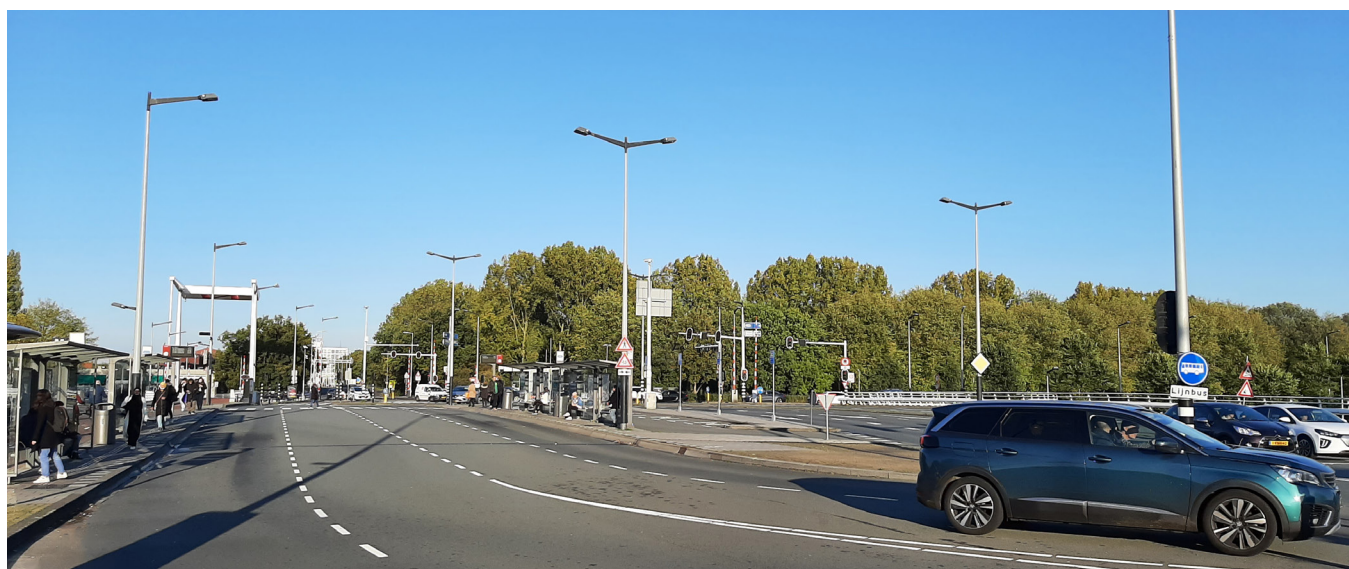
NPK-mast en -armatuur
