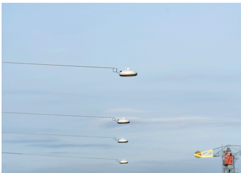
Overspanningsarmatuur 21e eeuw
